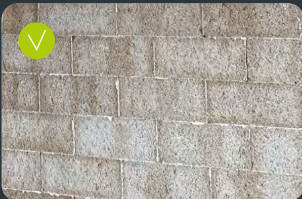
Buena ejecución de juntas
